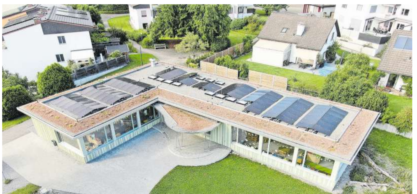
Eine Eigenenergieversorgung von 311 Prozent: der 2019 bezogene Kindergarten an der Schulhausstrasse in Mettmenstetten. (Bild zvg.)
